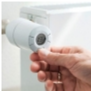
Монтаж термоголовки
